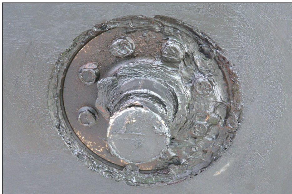
Foto 10: Hovedbolt inden fjernelse af fedt og scanning.
