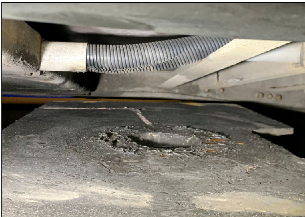
Foto 3: Mærke efter hovedbolt. Efter at have forladt skammellåsen har hovedbolten afsat et mærke på skammelpladen først mod venstre og dernæst bagud set ift. togets kørselsretning.
