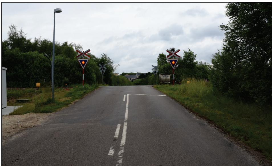
Foto 1: Overkørsel 63, der er aktiveret, set i bilens køreretning.
