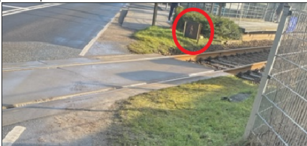
Figur 3: I den røde ring ses der til venstre for sporet mellem overkørsel og perron opsat et ”adgang forbudt” skilt. Kilde: Banedanmark.
