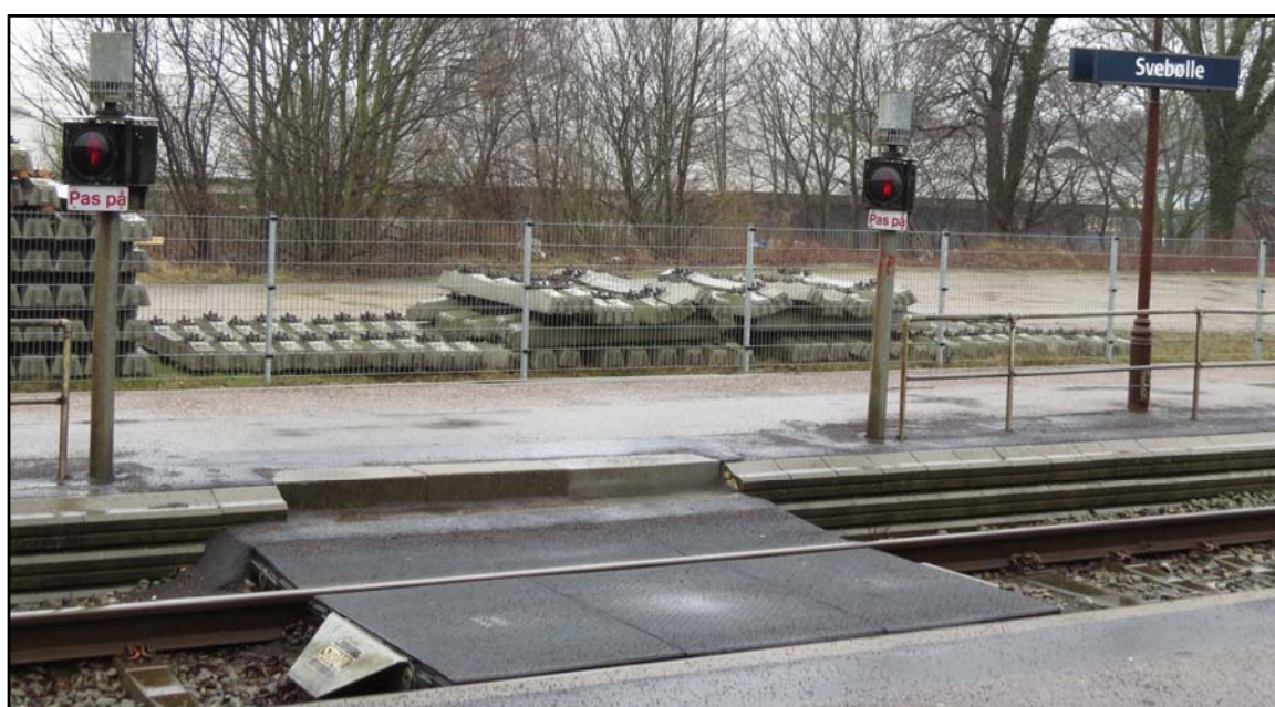
Perronovergang fra perron spor 1 til perron spor 2.
