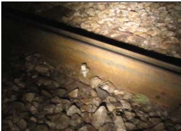
Fotos donde se aprecia el estado de sujeciones y traviesas. Fuente Renfe
