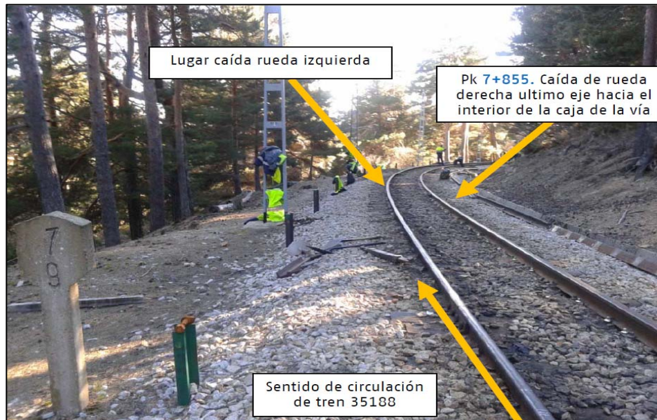
Vista de la zona donde se inicia el descarrilamiento. Fuente Adif.
