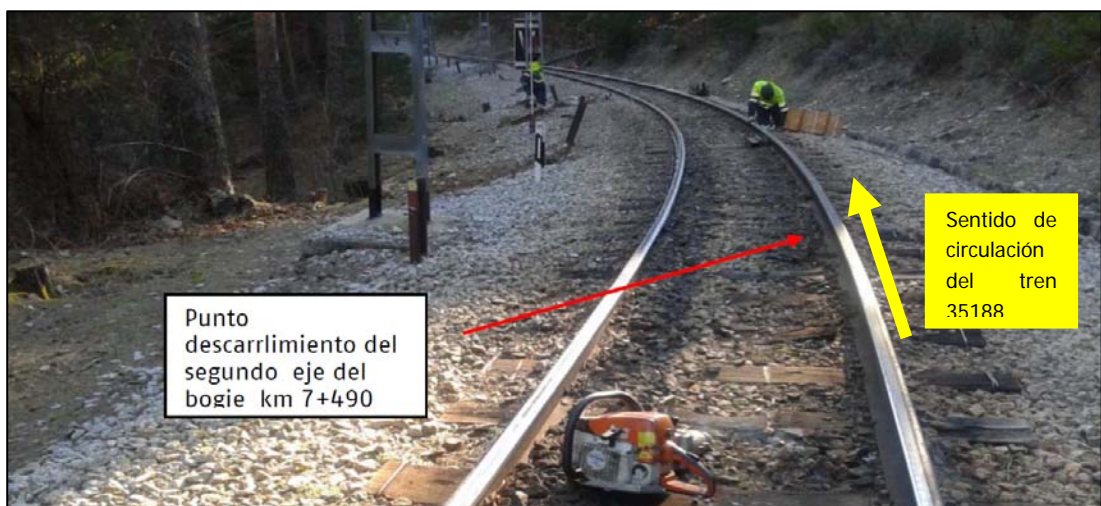
Vista de la zona donde descarrila el otro eje del segundo bogie. Fuente Adif.
