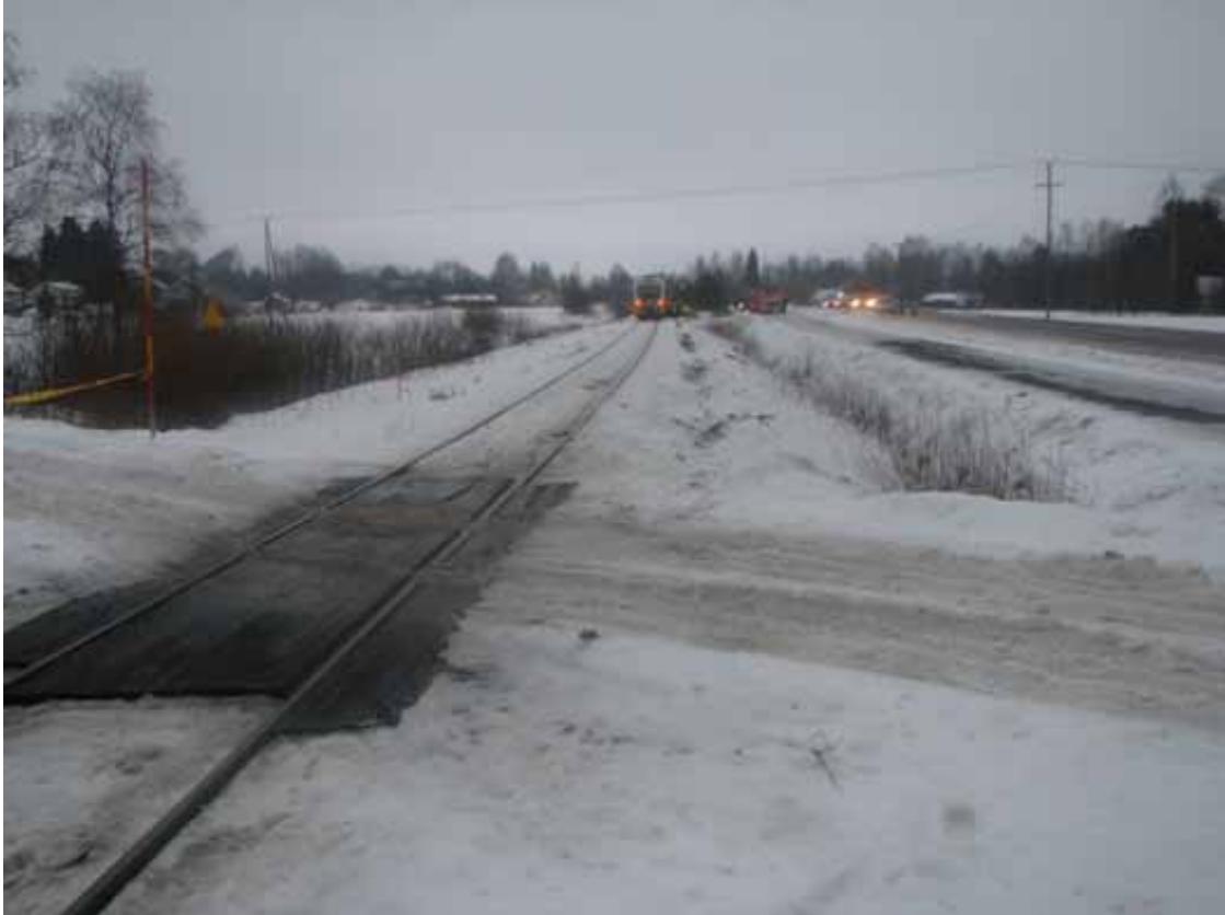
Kuva 6. Auton tulosuunta tasoristeykseen oli kuvassa oikealta. Tien pinnalla oli sohjoa. Kauempana näkyy kiskobussin pysähdyspaikka törmäyksen jälkeen.
