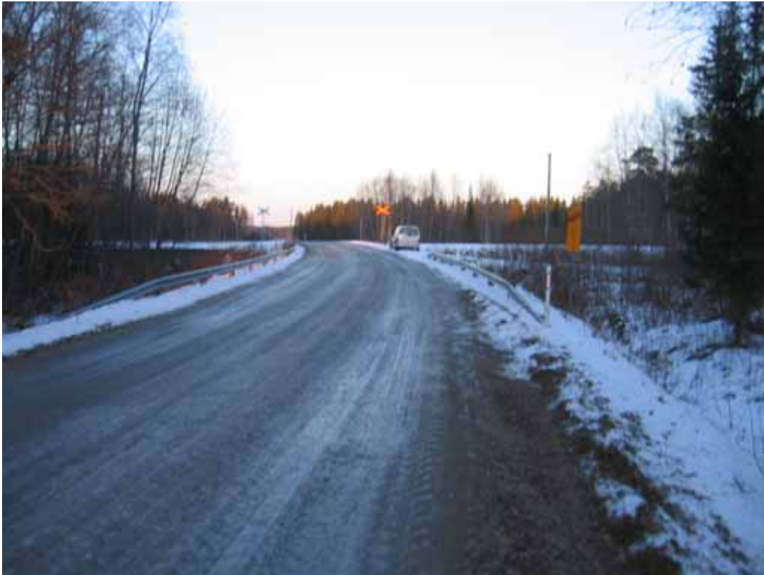
Kuva 3. Tasoristeys onnettomuusauton tulosuunnasta.
