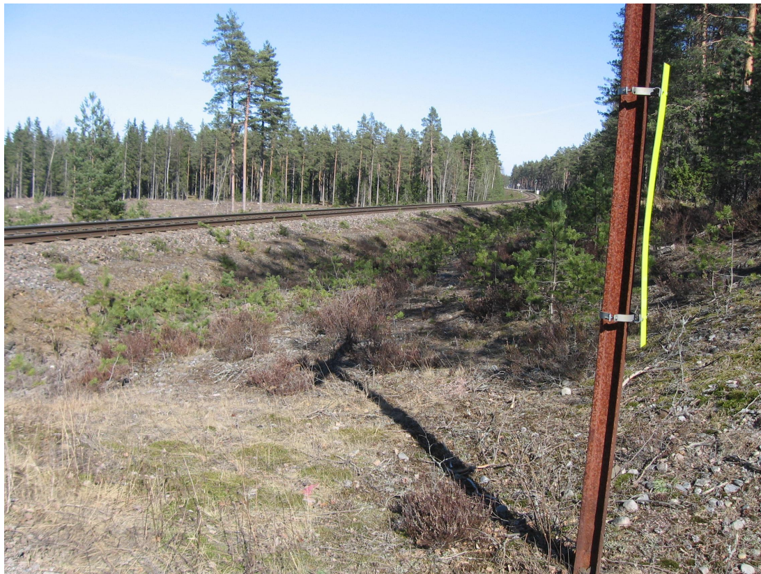
Kuva 5. Näkymä junan tulosuuntaan tasoristeysmerkin kohdalta.
