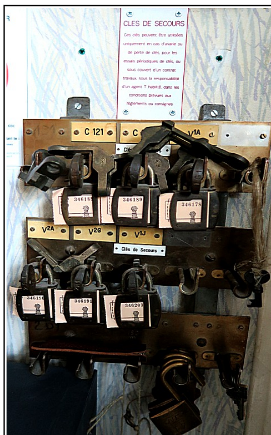
Fig. 7 : Exemple de support regroupant des cadenas à ouverture contrôlé
