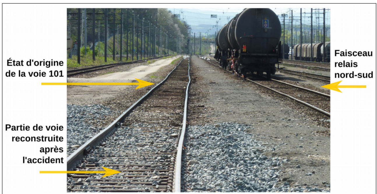
Figure 7 : l'état général de la voie en avril 2017
