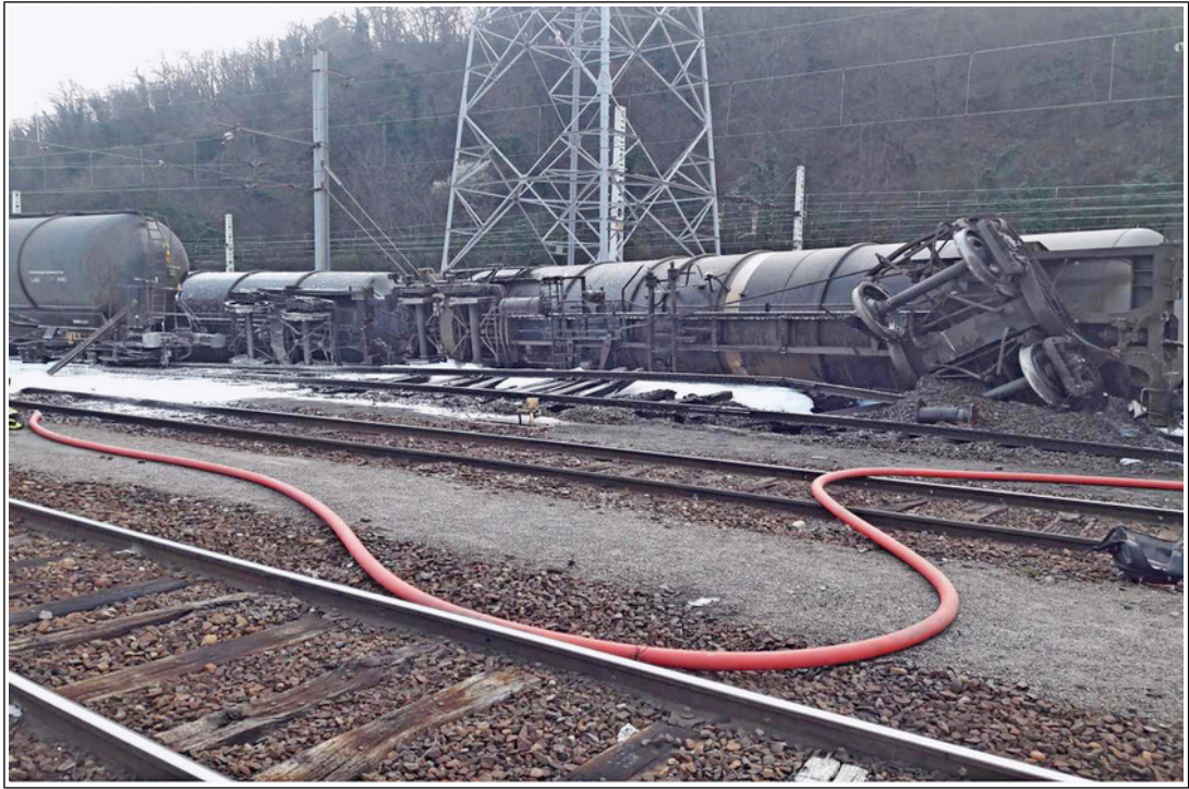
Figure 2 : les deux wagons couchés et la voie emportée
