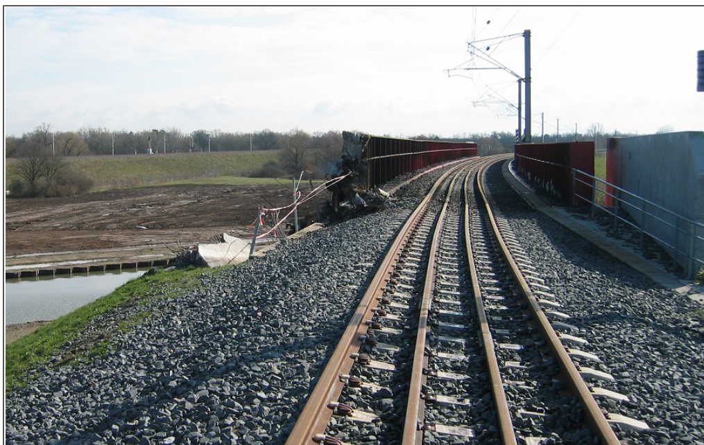
Figure 6 : La voie 2 avec ses rails de sécurité aux abords du pont sur le canal
