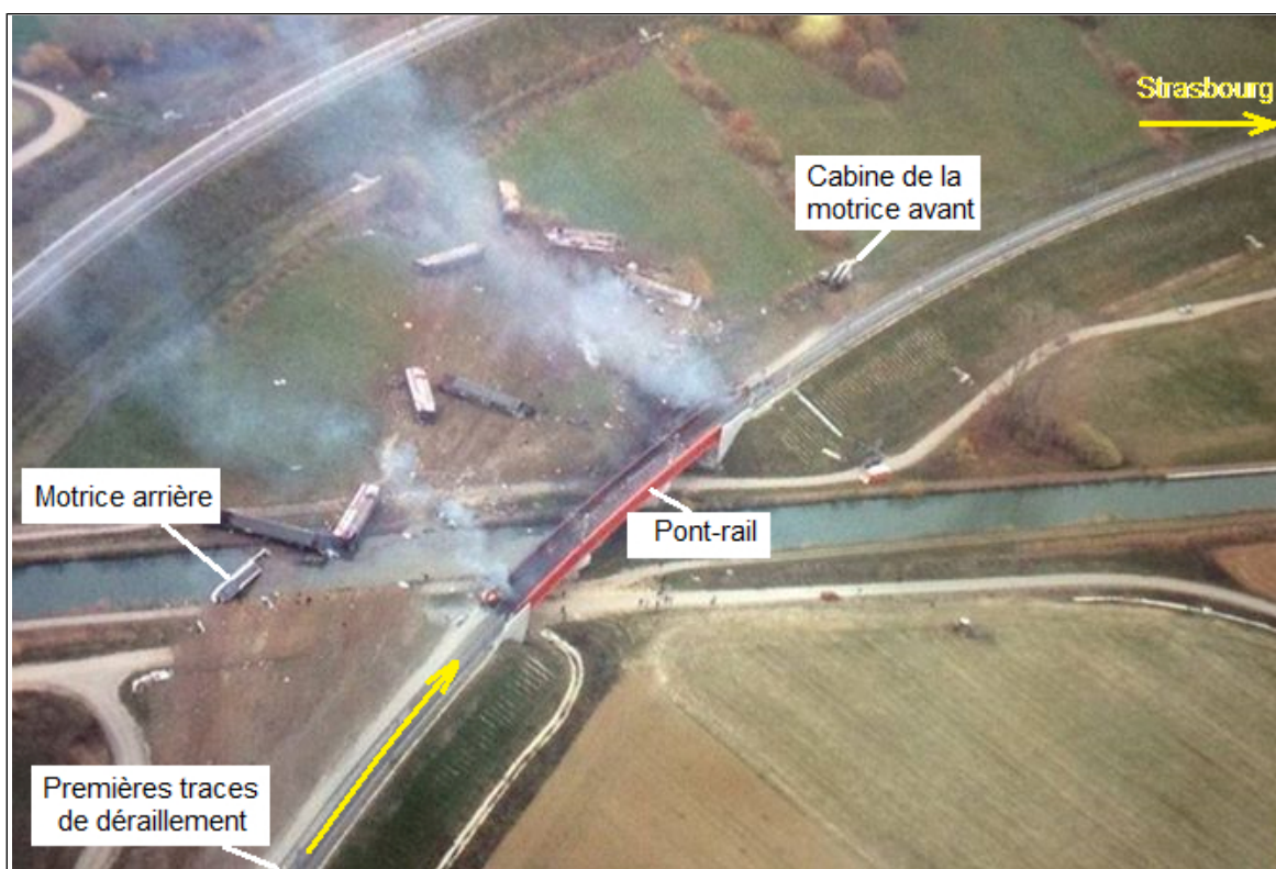
Figure 1 : Vue générale du site de l'accident
