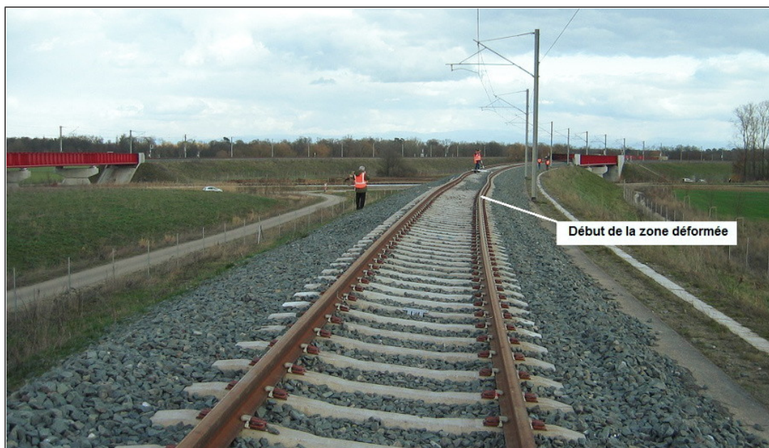
Figure 20 : Vue de la Voie 2 en direction de Strasbourg
