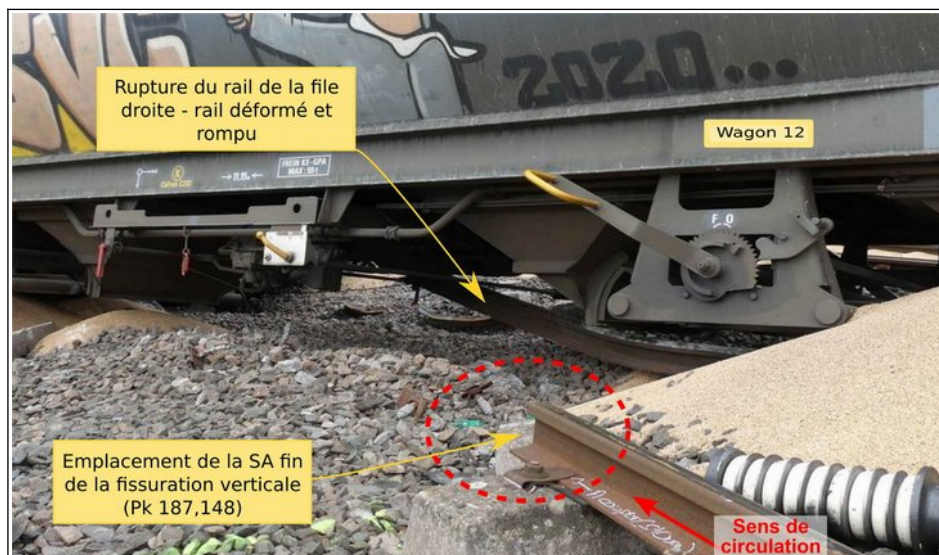
Figure 29 : vue au niveau de la rupture
