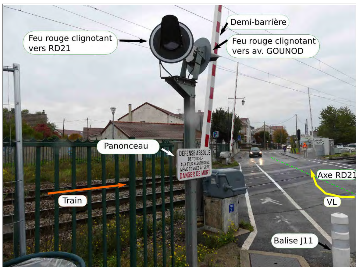
Figure 17 : signalisation au droit du PN, côté gauche photo et légende BEA-TT
