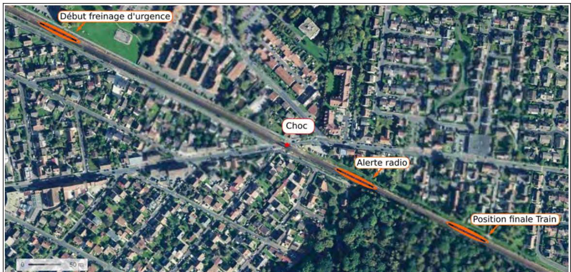
Figure 26 : localisation des actions de l'agent de conduite d'après l'enregistreur du train vue aérienne Géoportail-IGN, légende BEA-TT
