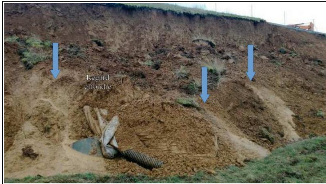
Figure 39 : les écoulements dans les loess (photo expert judiciaire le 12/03/20)
