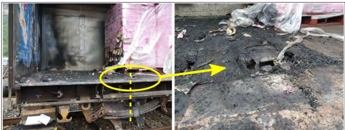
Figure 21 - vue de la zone perforée du plateau à l'intérieur du wagon (photos BEA-TT)
