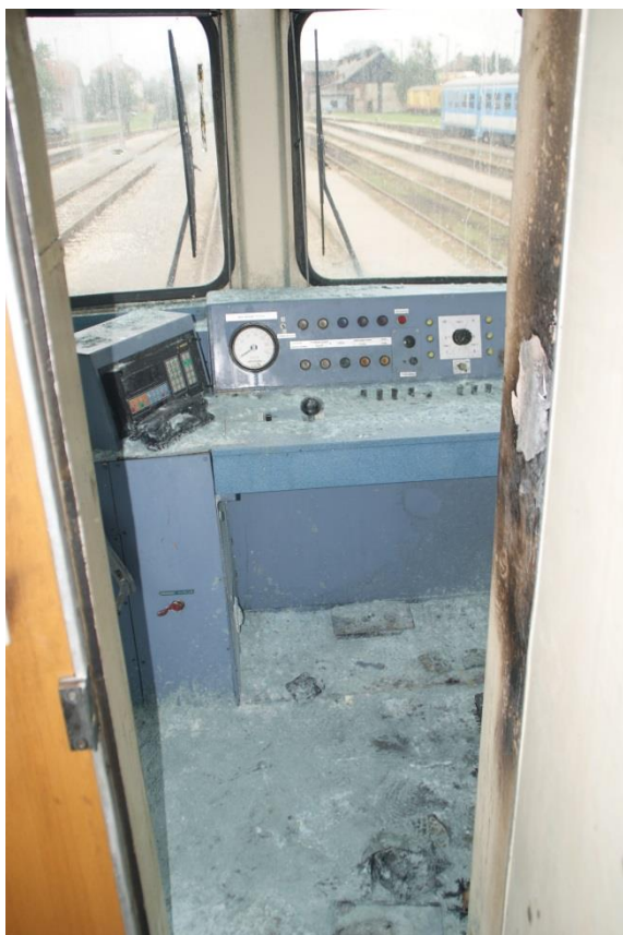
Slika 6. Ulaz u stražnju upravljačnicu (Izvor PUVŽ)
