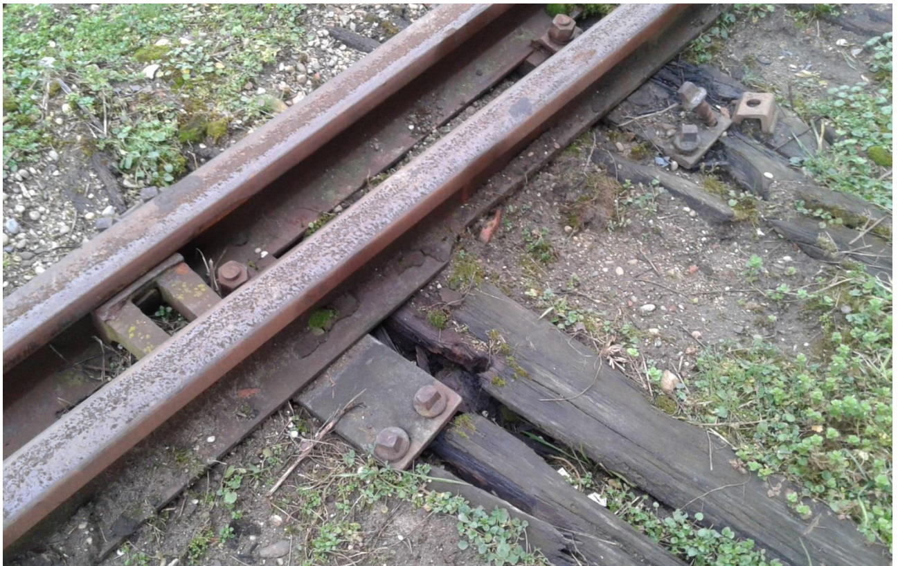
Slika 8 Stanje pragova i pričvrsnog pribora kod skretnice broj 36 (Izvor AIN).
