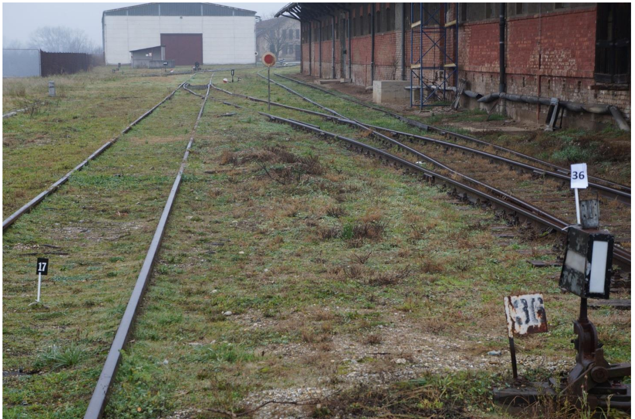
Slika 13 Spojni kolosijek između skretnica 36 i 37 (izvor AIN)
