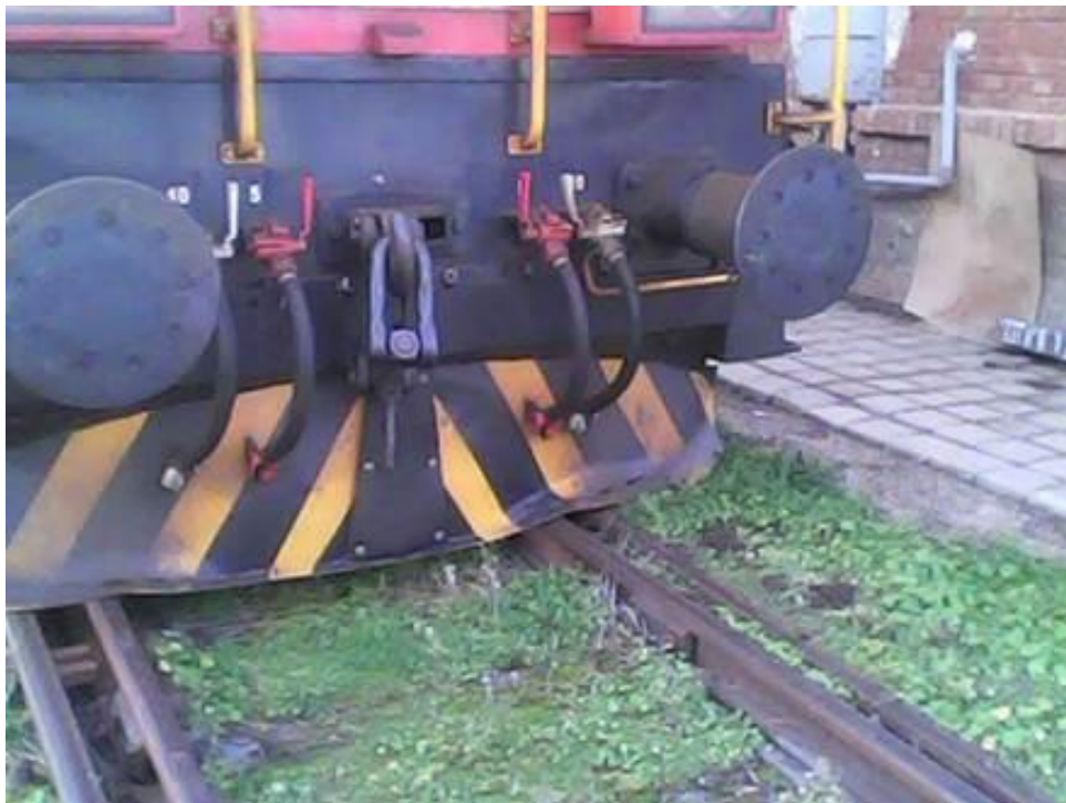
Slika 10 Oštećenja na plugu lokomotive (Izvor AIN).
