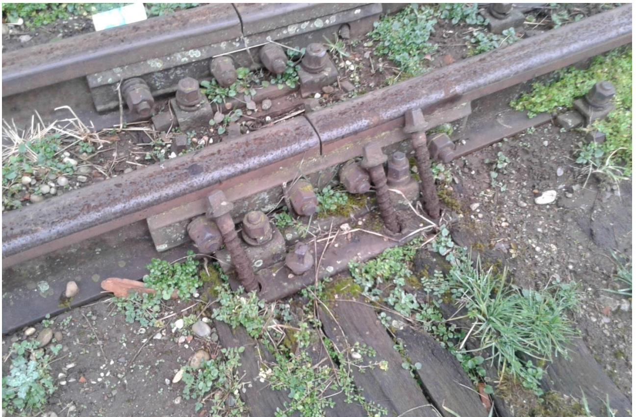
Slika 9 vijci ručno izvađeni iz pragova (Izvor AIN).
