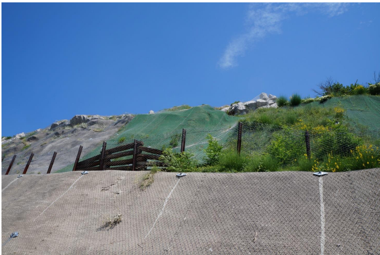
Slika 12 prikaz sanacije odrona u usjeku na pruzi između kolodvora Labin Dalmatinski i Kaštel Stari
