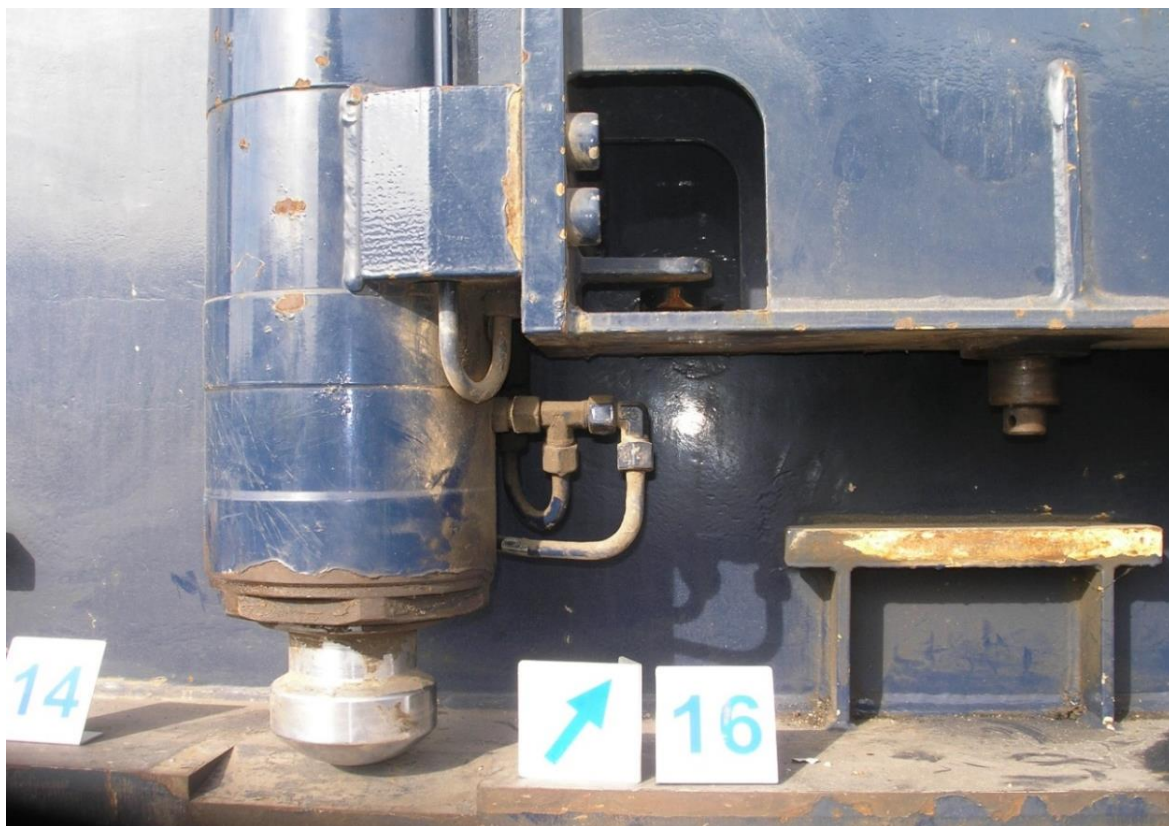
Slika 5 stabilizator kojem nedostaje svornjak (Izvor AIN).
