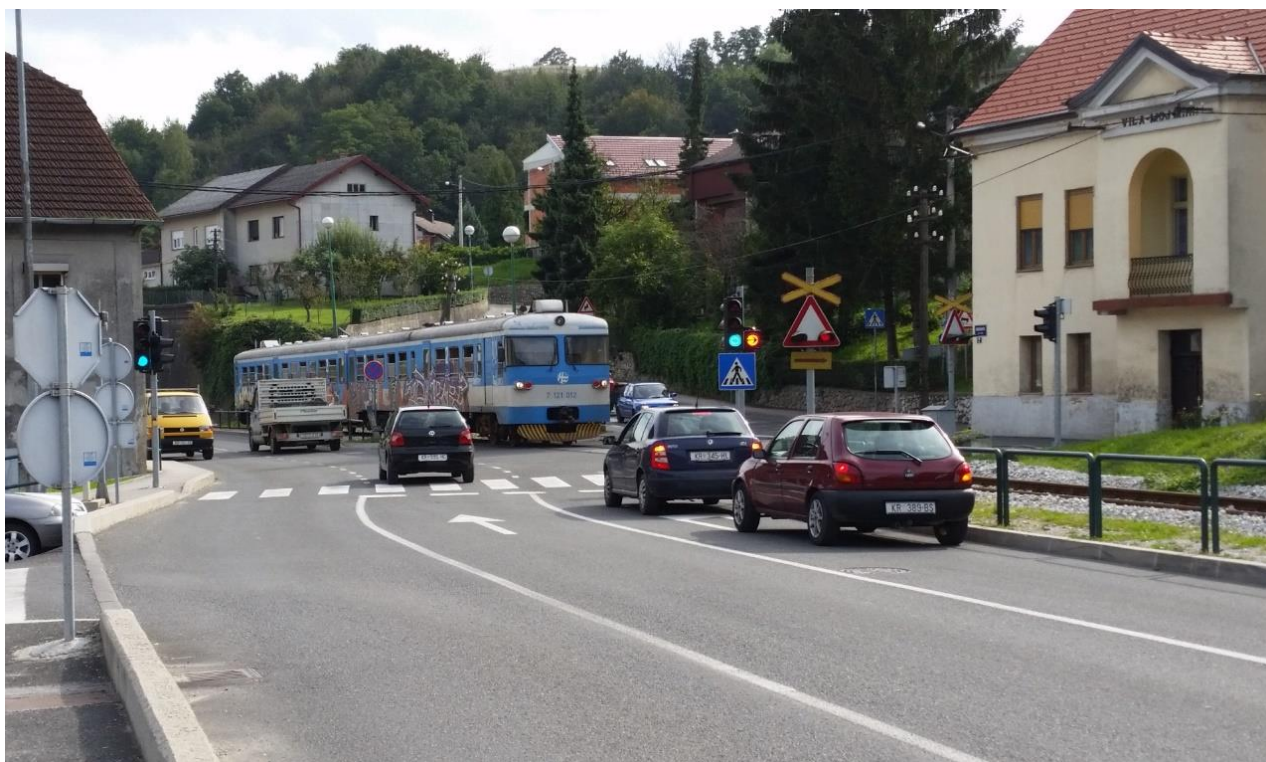
Slika 11 – Svjetlosna signalizacija na predmetnom ŽCP-u (Izvor AIN).
