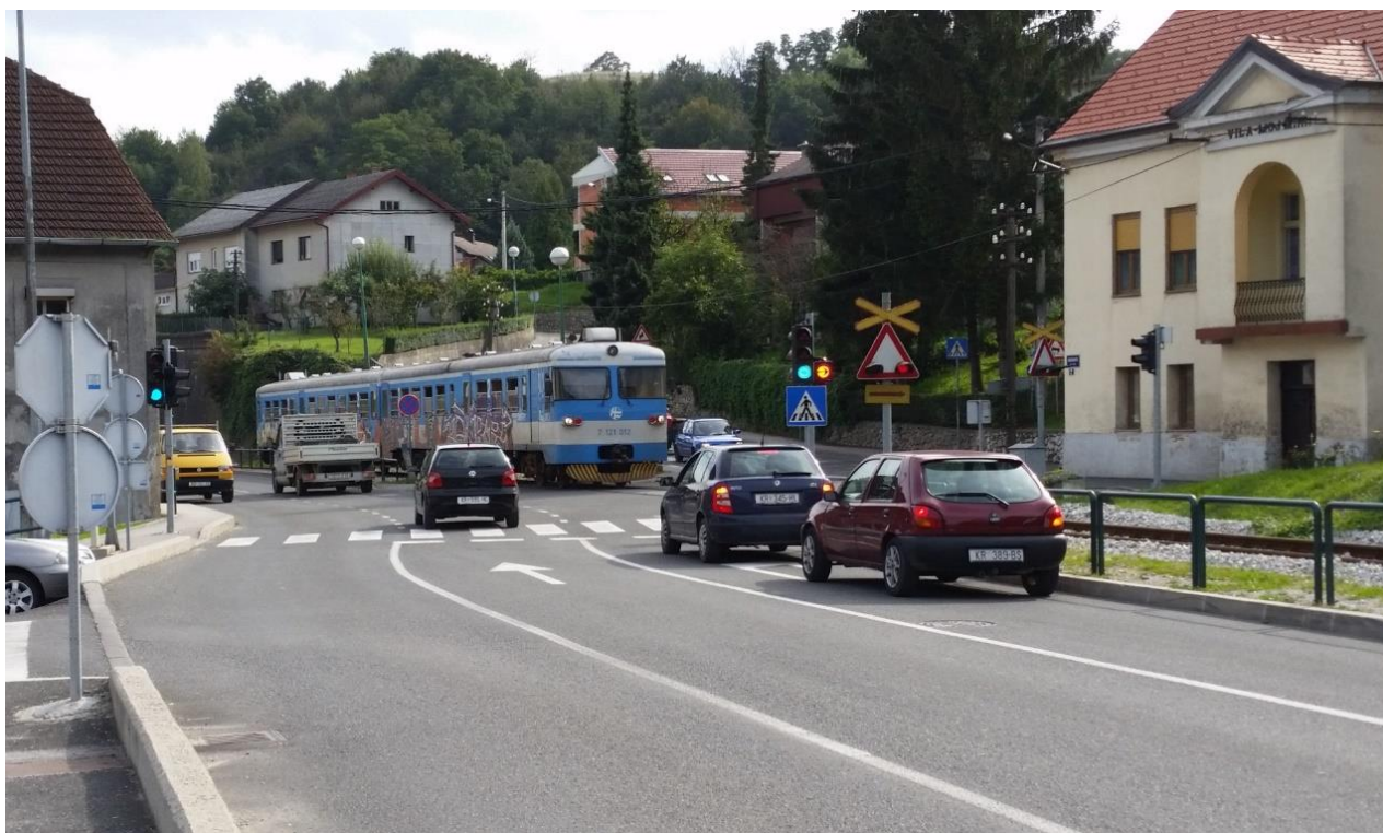
Slika 11 – Svjetlosna signalizacija na predmetnom ŽCP-u (Izvor AIN).
