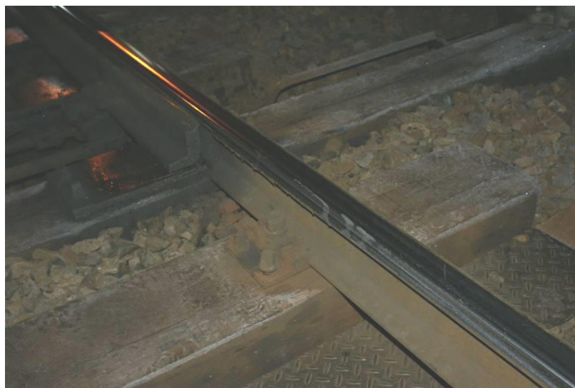
4. ábra A 3 sz. átszelési kitérő kopott tősinje
