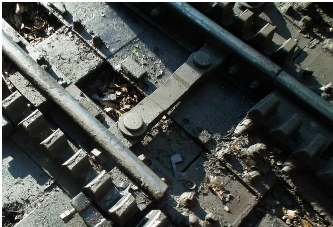
5. ábra: összekötő rúd a közbenső rész váltójában (helyreállítás után)
