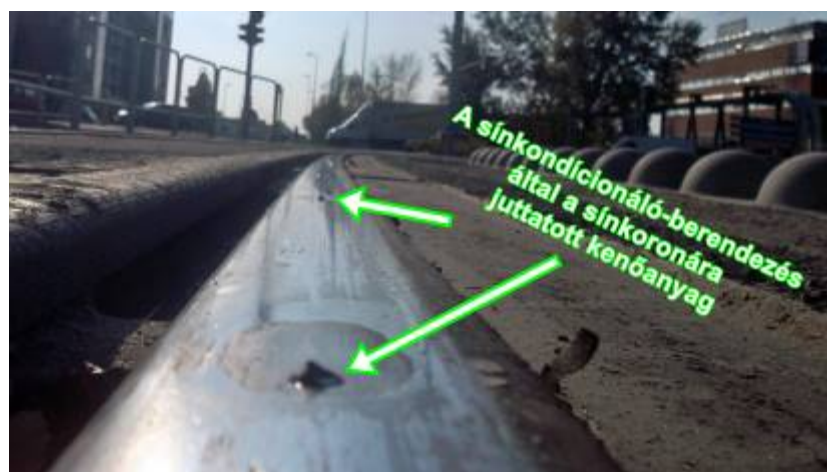
6. ábra: Sínkondicionáló berendezés az eset helyszínén
