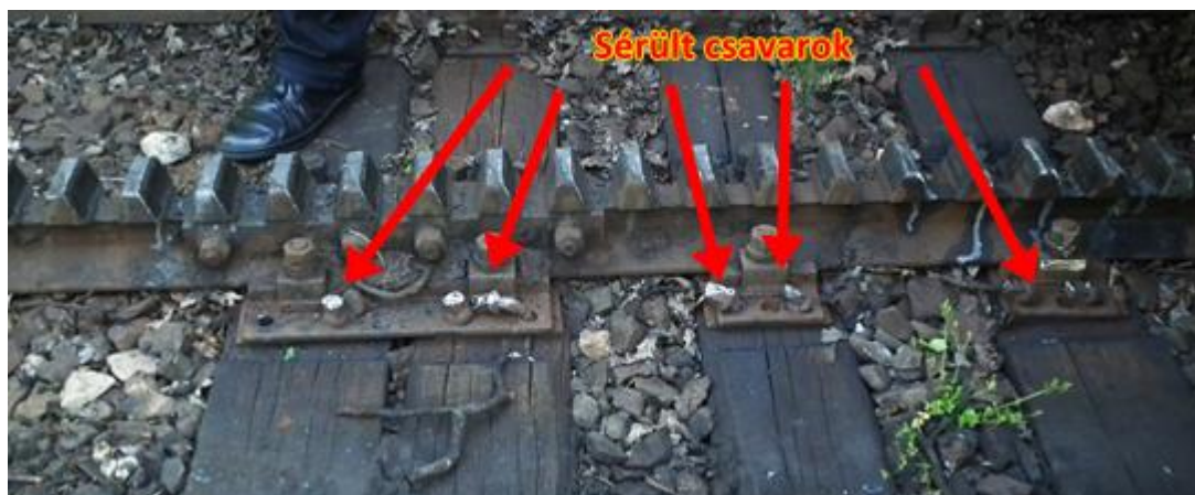
4. ábra: a sérült csavarok az eset helyszínén (2016. május 22. -Széchenyi-hegy)
