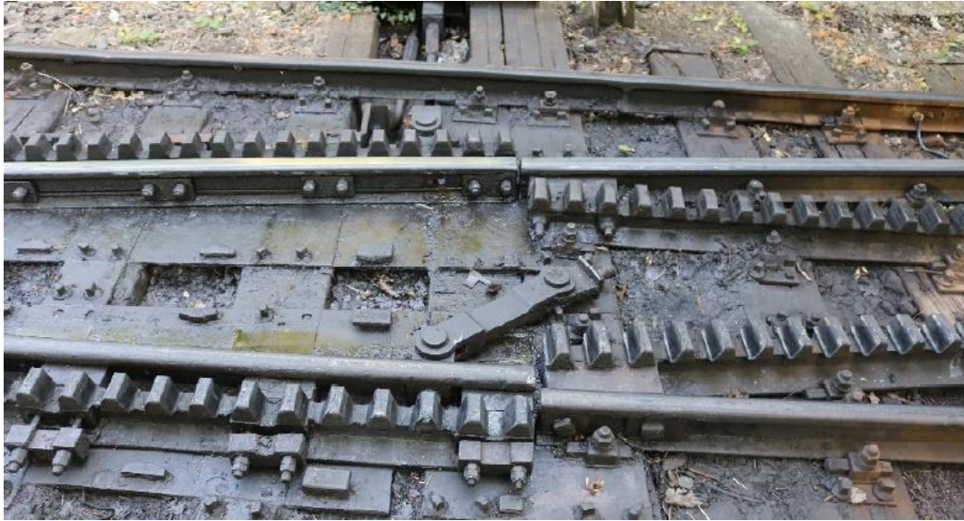
8. ábra: a szétesett összekötő rúd a szeptemberi esemény után (fotó: BKV Zrt.)
