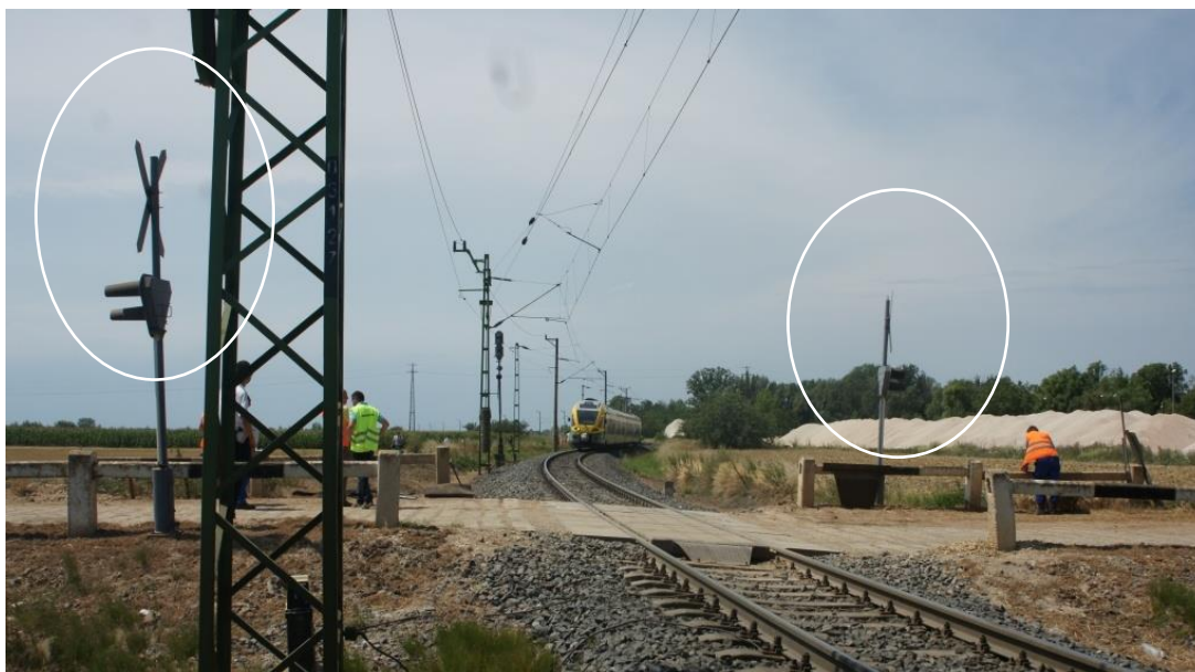
6. ábra: A szabályosan elhelyezett "Vasúti átjáró kezdete" jelzőtáblák
