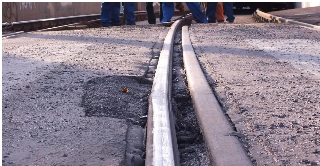
9. ábra: irányhiba a bal sínszálban
