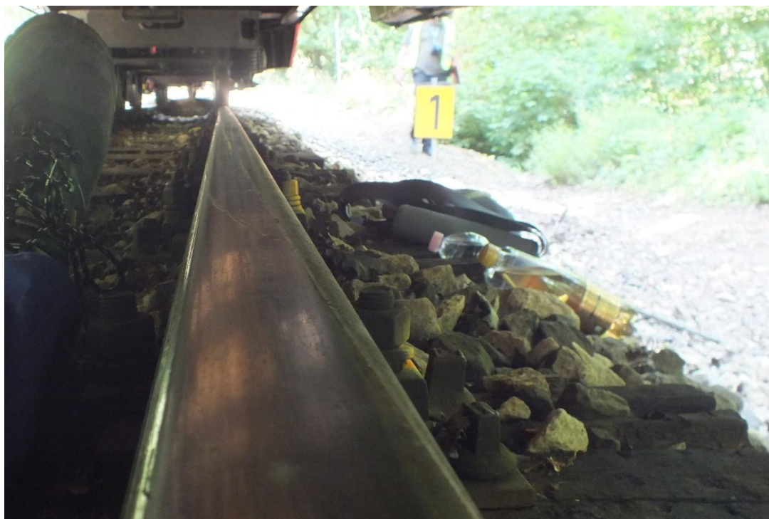
5. ábra: kisiklási nyomok, a menetiránynak ellentétesen nézve
