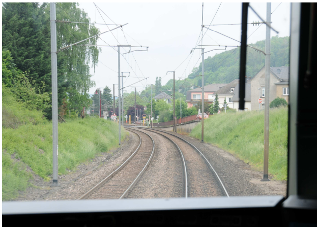
Photo prise à l'intérieur de la cabine d'une automotrice Z2 à l'approche du PN au PK 25.200
