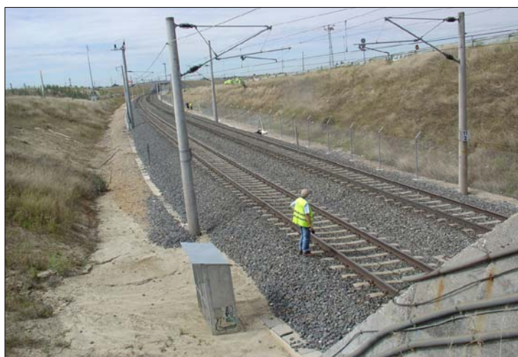
Vista de la plataforma desde el emboquille sur del túnel de Perales (fuente: Renfe Operadora)
