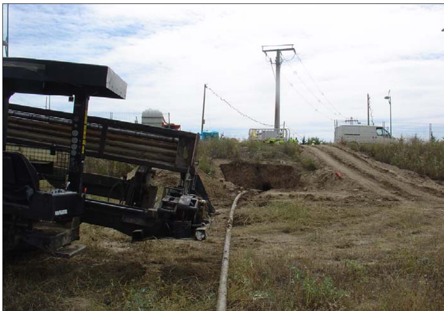
Pozo de ataque (Fuente: Renfe Operadora)
