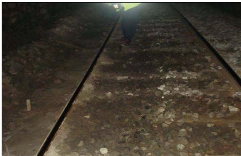
Hilo Bajo contaminado interior del túnel del Caracol. (Fuente Adif)
