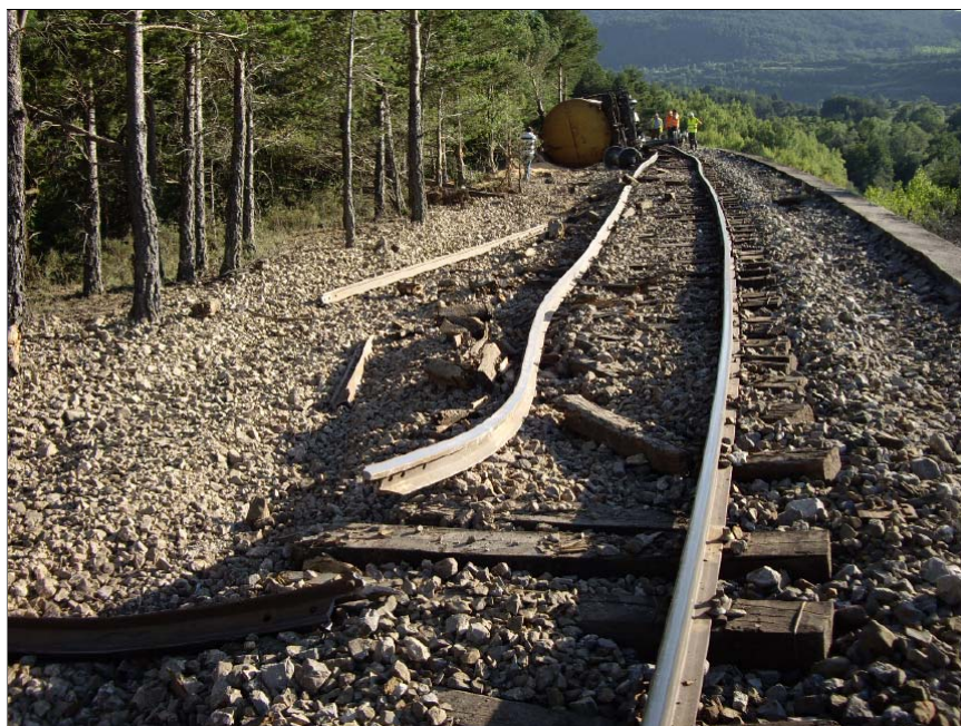
Estado de la vía tras el descarrilamiento. (Fuente Renfe Operadora)
