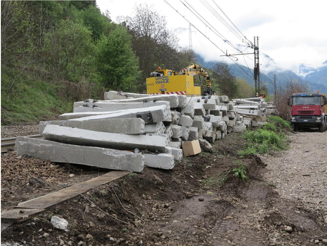
Figura 25 - Traverse cadute dai carri in seguito all'urto
