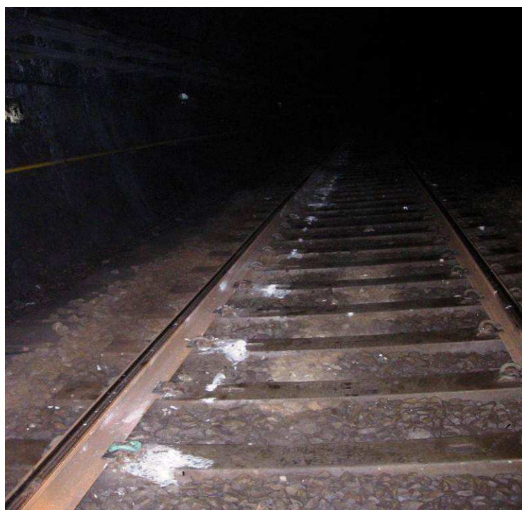
Figura 5 – Primi segni della caduta di una ruota sulle traverse (fonte: RFI)
