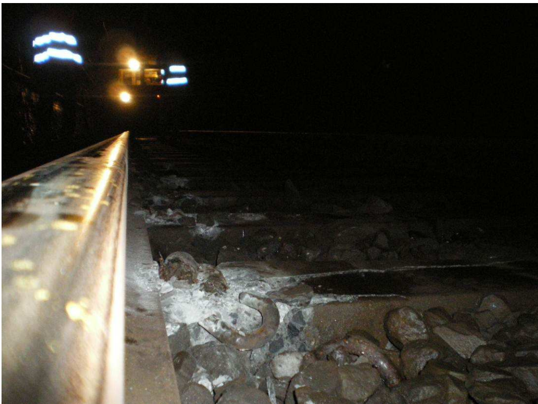
Figura 12 - Segni di caduta sulle traverse
