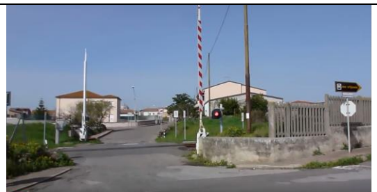
Figura 21 - Avviso luminoso della lanterna semaforica di imminente chiusura delle barriere del PL: visuale ortogonale al PL lungo via Cimitero
