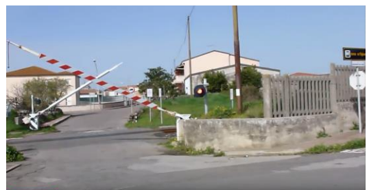
Figura 31 –Barriere in fase di movimentazione
