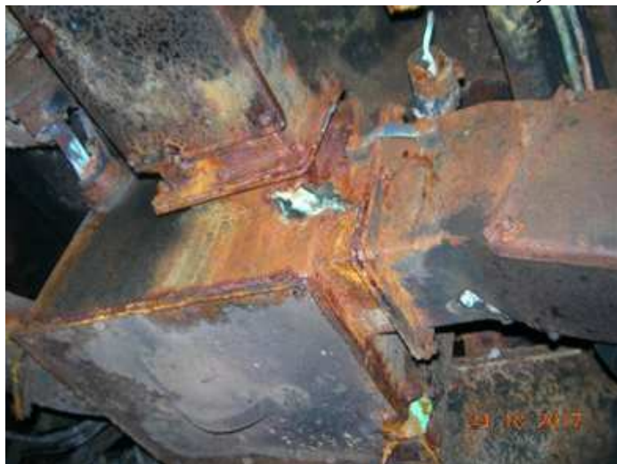
Figura 6 - Cablaggi circuito di comando sotto cassa (fonte Mercitalia Rail)
