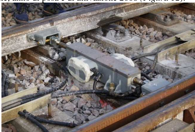
Figura 12 - Armamento infrastruttura in prossimità del punto di svio (fonte: DiGiFeMa)
