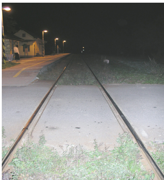
Foto 2: Foto přejezdové vozovky
