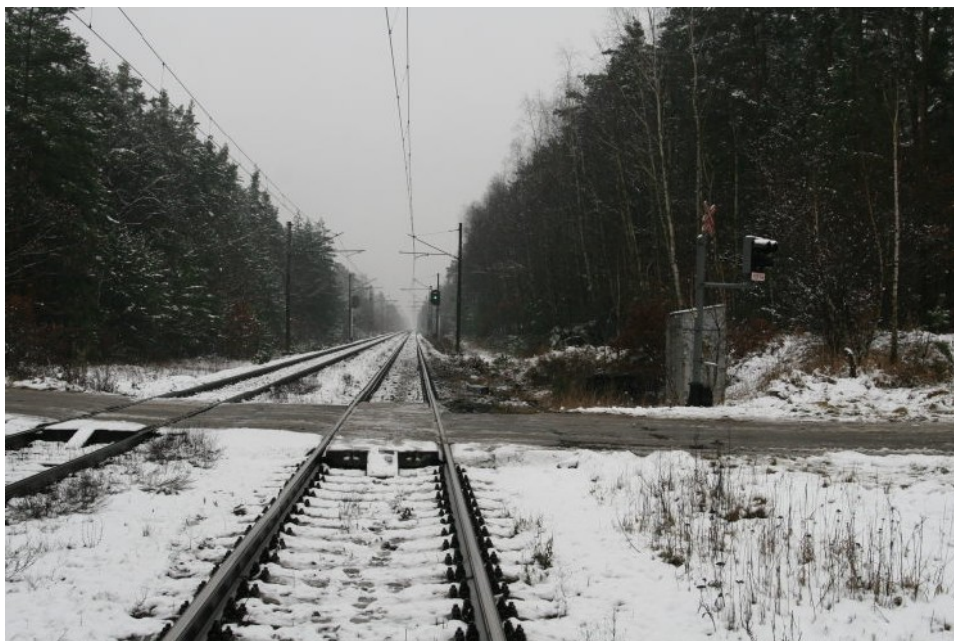
Foto 7.1 Železniční přejezd v km 343,109 ze směru jízdy vlaků Os 6409 a Pn 65401
