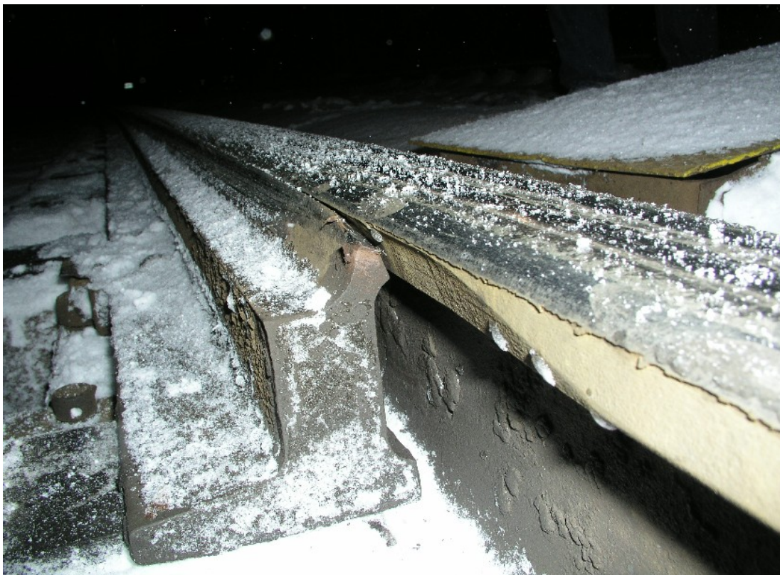
3. Pohled na komisionálně stanovený bod "0" - první stopa po vykolejení HDV řady 742.126-6 na výhybce č 15 žst. Bystřice nad Olší v km 305,520 trati Mosty u Jablunkova st. hr - Bohumín. Naražený hrot pravého ohnutého jazyka po odtažení nevykolejených TDV
