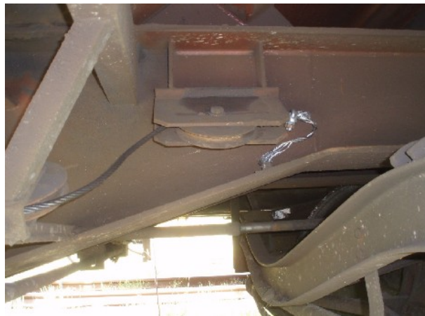
Obr. 8. Vyvlečené oko lana od pístnice brzdy
