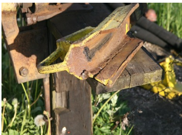
Obr. 3. Poškozená přírubová zarážka
