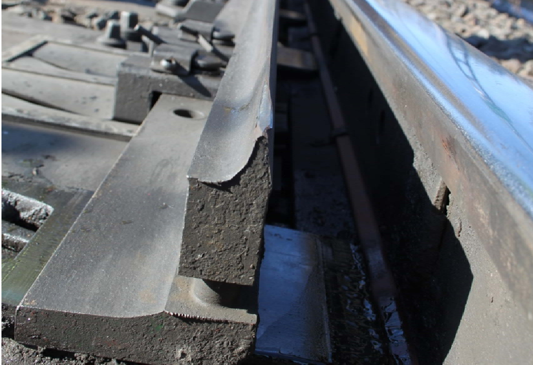
Kuva 6. Kiinni olleen kielen kärjessä ja tukikiskossa olleet iskujäljet.
