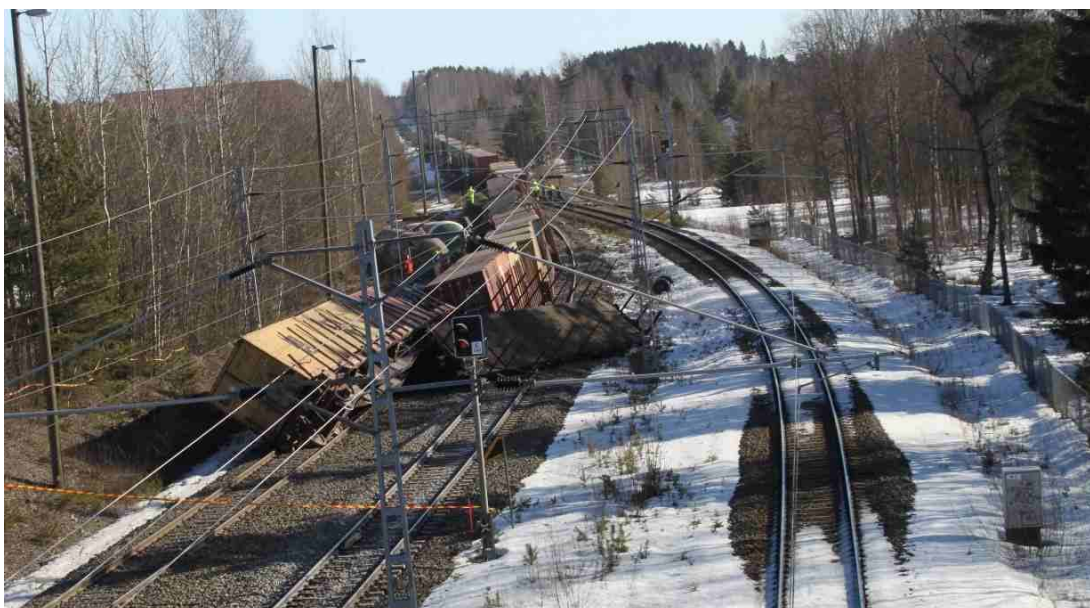
Kuva 3. Vaunut suistuivat vaihteessa V003. Kaksi säiliövaunua kaatui raiteelle 043, yhdeksän vaunua suistui kiskoilta raiteelle 041 (keskimmäinen raide, jota pitkin junan oli tarkoitus kulkea) ja raiteiden 041 ja 043 väliin. Venäläisten ja suomalaisten vaunujen välissä ollut välivaunu suistui vasemmalle vaurioittaen lievästi raidetta 042. Junan loppupään 16 vaunua jäi kiskoille.
