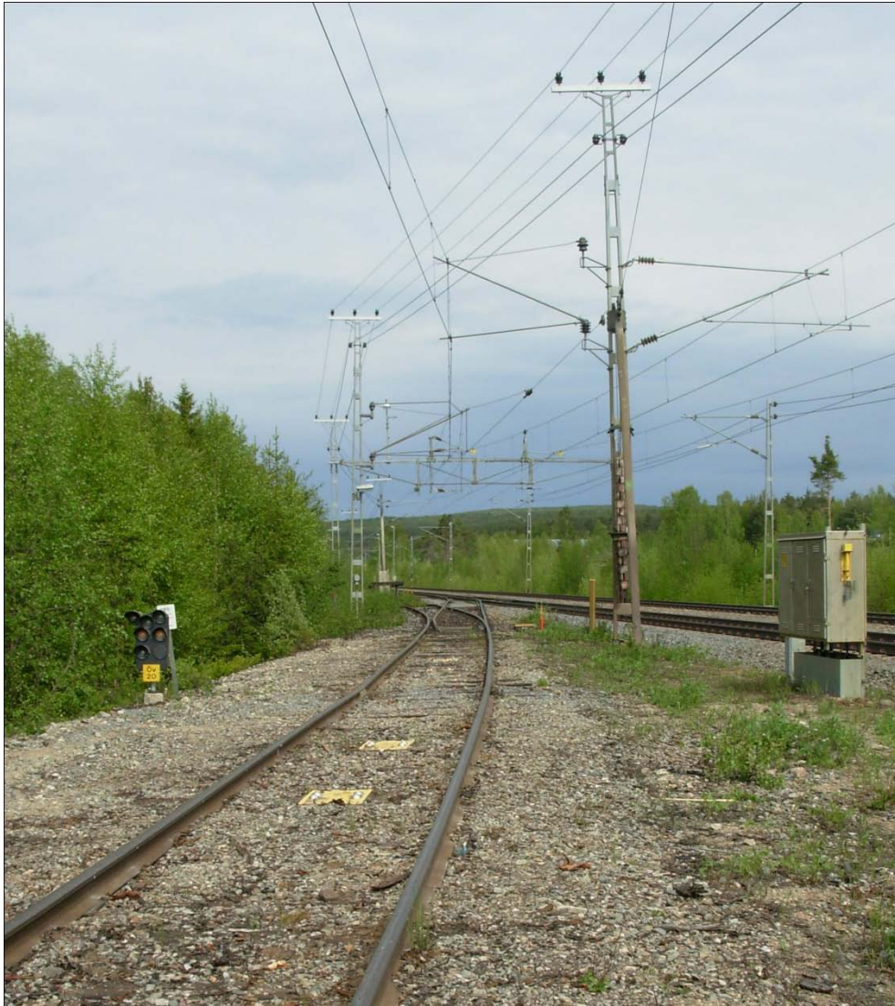
Fig. 6 Timmerterminalens anslutning mot huvudspåret. Huvuddrängsignal Öv 20 syns till vänster om spåret och skyddsväxeln strax bakom.
