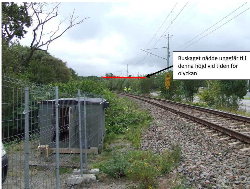
Fig. 2 Plankorsning Solgården. Riktning söderut. Staket har satts upp och buskage har röjts efter olyckan. Bakom staketet syns den kur som innehåller den tekniska utrustning som styr vägskyddssignaleringen. Kameran är i ögonhöjd på en person som är 1,80 m lång.
