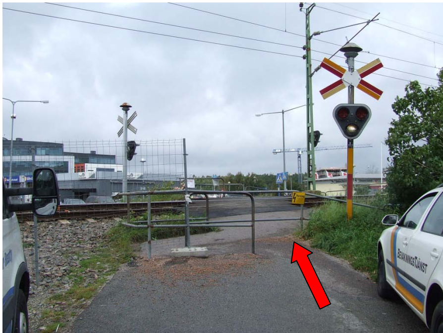
Fig. 1 Plankorsning Solgården. De personer som omkom på plankorsningen gick i pilens riktning.
