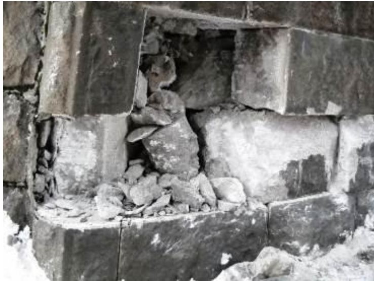
Figur 9. Detaljerad islagspunkt.
