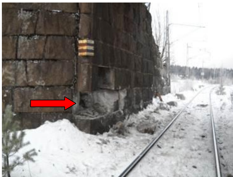
Figur 8. Spårport där stålämnet först träffade.
