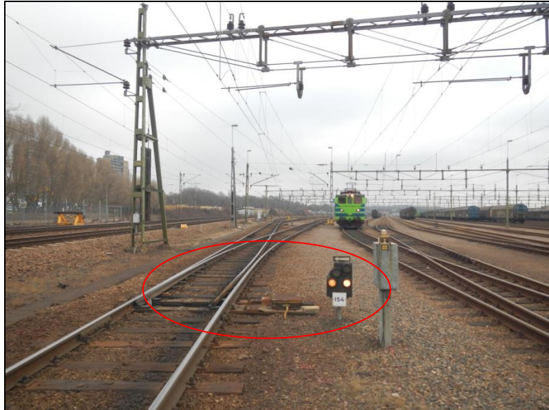
Figur 2. Den röda cirkeln visar växel till avvikande huvudspår 3-8 på Helsingborgs godsbangård och till höger om växeln den växlingsvärgsignal som passerades obehörigt. Spår 6 används huvudsakligen som ankomstspår för tåg samt för växlingsrörelser som kommer från containerterminalen samt hamnbanorna. Spårerna till vänster om växeln är normalhuvudspår, spårerna till höger om växlingsvärgsignalen är sidospår på godsbangården. Foto: SHK.
