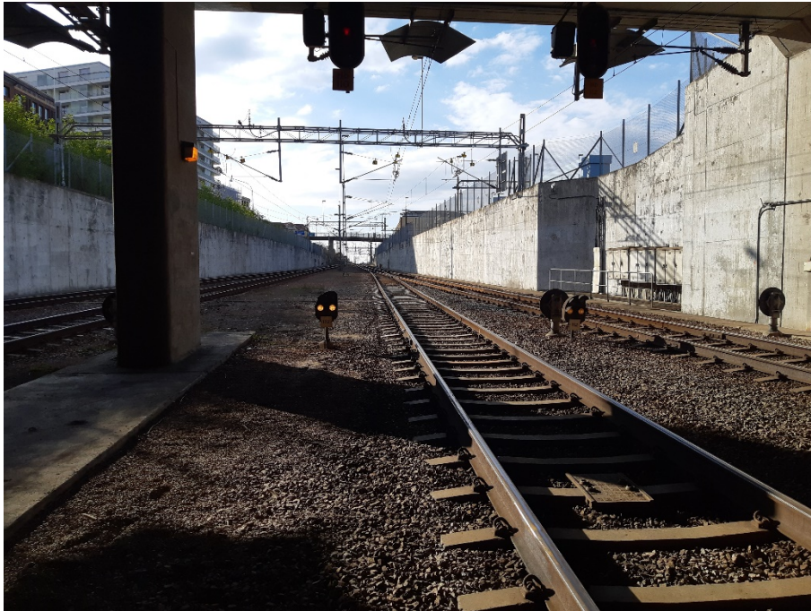
Figur 18. Dvärgsignal 110 i ”stopp” med magasinerad växlingsväg till spår 8. Foto: Infranord.
