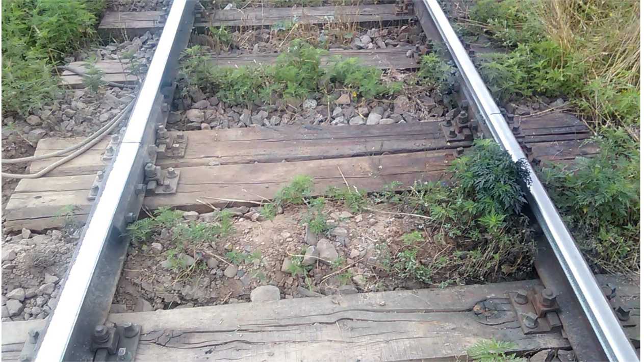
Fig. 8 – fotografia cu zona colmatată
