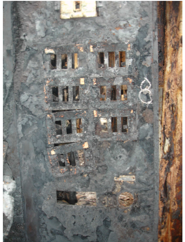
Foto nr.7 – Blocul S8
