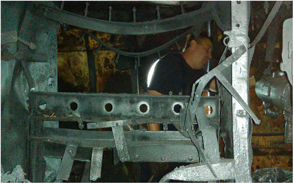
Foto nr.4 – Blocul S4, cadru susținere contactori
