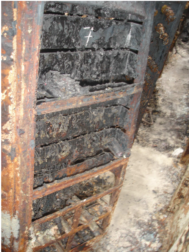
Foto nr.6 – Blocul S7
