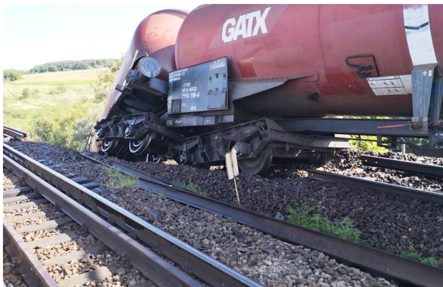
Foto nr. 7- Terasamentul din spatele culeei Malu Mare (culeea C1) șine, contrașine interioare, contrașine exterioare și traverse scoase din cale
