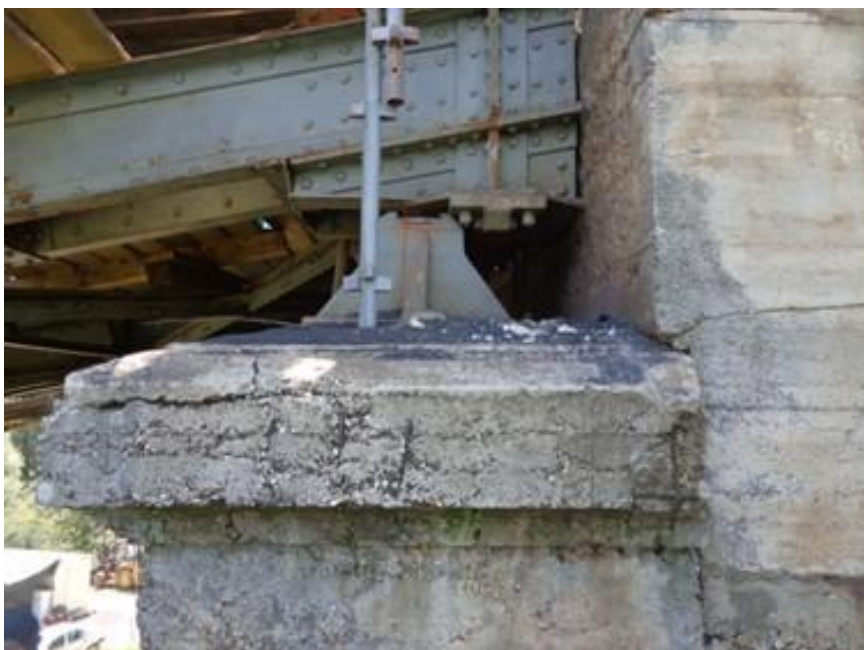
Foto nr.15- deplasarea spre culeea C2 a tablierului III
