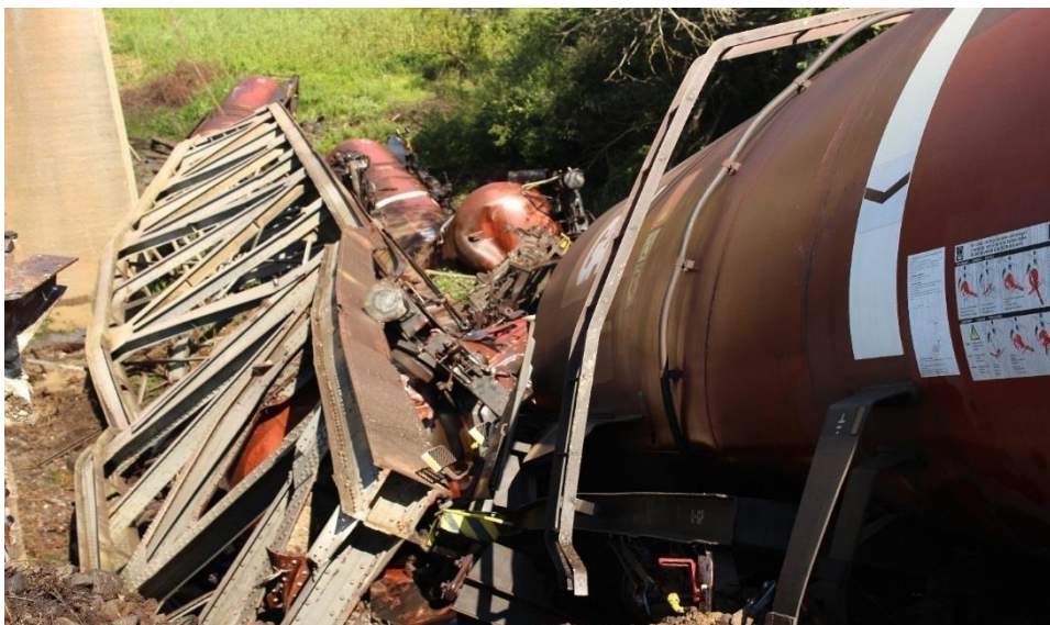
foto 12- tablierul I după prăbușire
