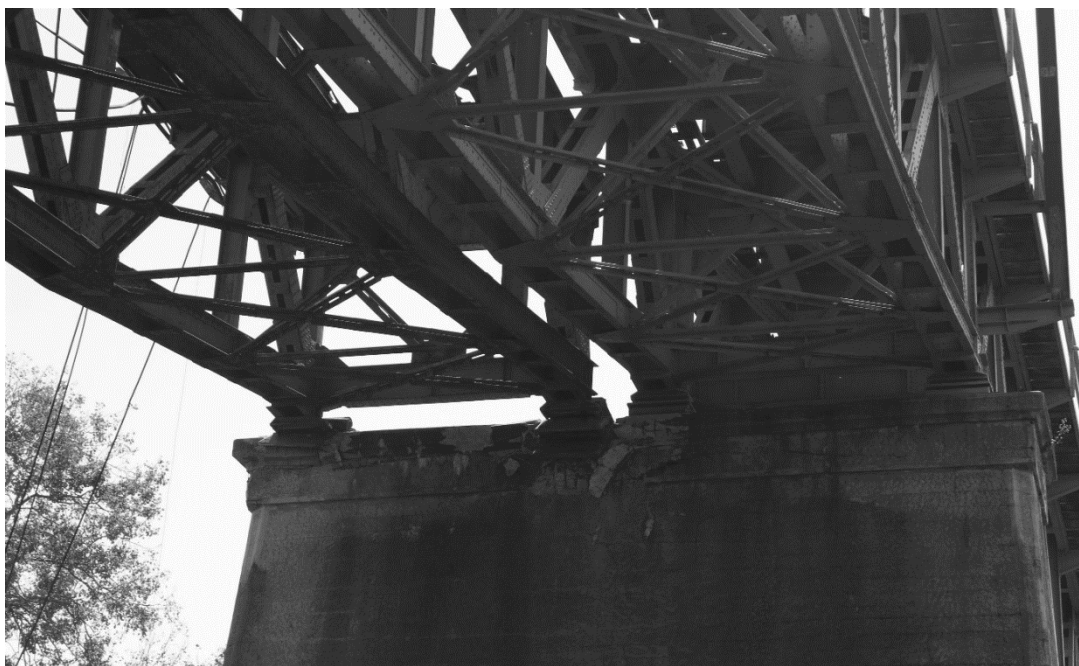
foto nr.14- rezemarea pe pila 1 a tablierului II de pe firul I (pericol de cădere a acestui tablier)
